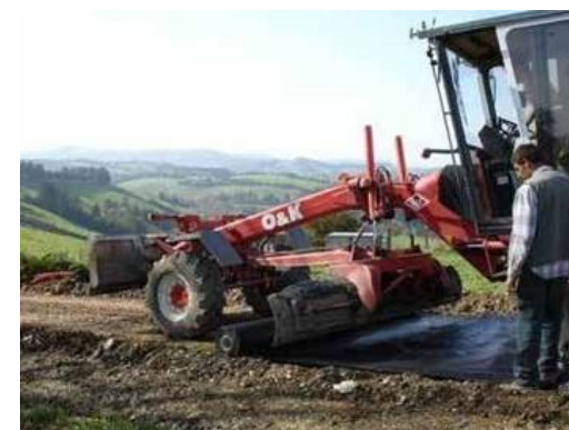
Pose du géotextile
