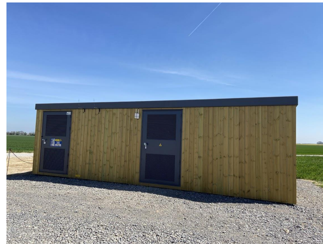
Poste de livraison du parc éolien de Marendueil (SOMMEREUX - 60)
