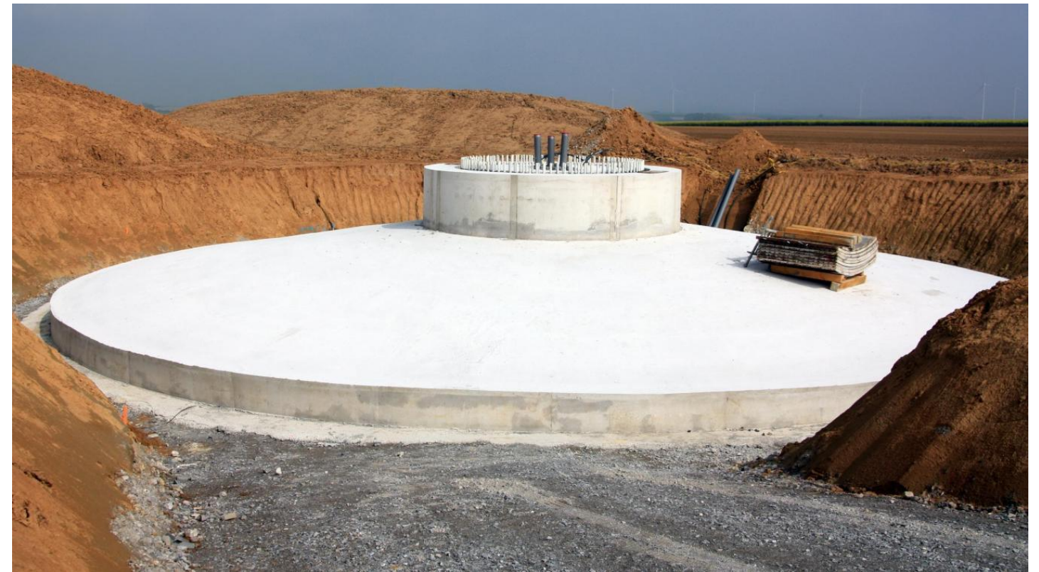
Socle béton d'une éolienne
