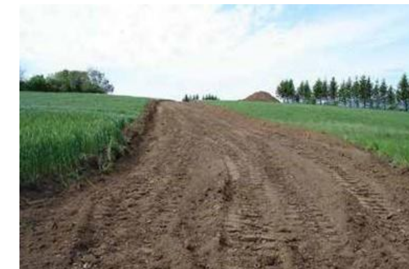
Mise en place du gravier
