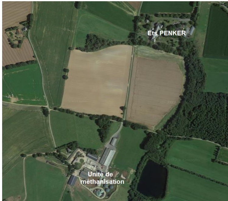
Unité de méthanisation du Lintan (2015)
