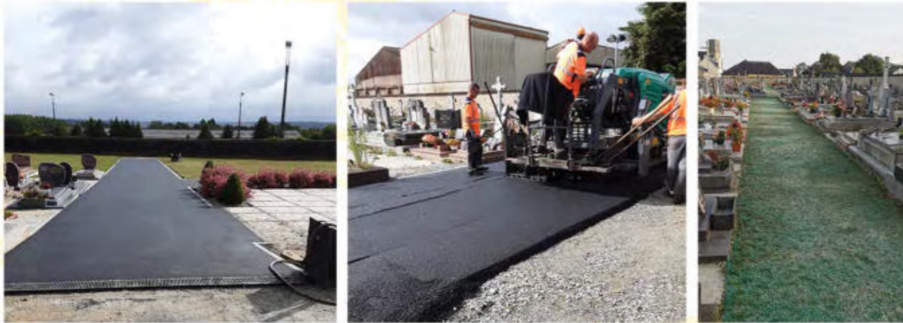
Aménagement d'un tourne à gauche au lieu-dit Kercoquin
